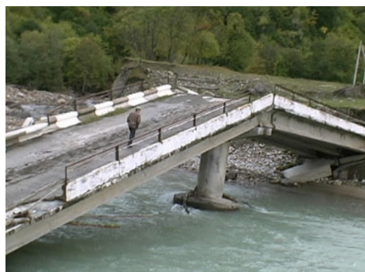
Обрушение мостов в результате высокого абразивного износа
